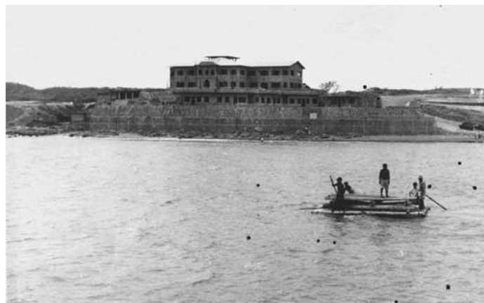
Foto: Hotel Humboldt en construcción. Gral. Villamil. Archivo personal, Alex Yagual
