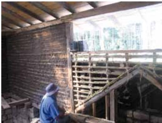
El carrizo o el zuro se pueden colocar en parejas o de manera individual, siempre teniendo presente que la separación entre uno y otro debe permitir la introducción del barro como embutido. Es imprescindible que estos materiales estén debidamente secos para evitar que al secarse ya colocado, la reducción del carrizo lleve a aflojar el amarrado y por consiguiente quedaría el entramado suelto en ciertas partes.
