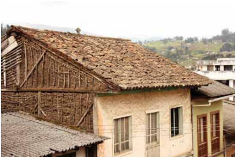
**Recubrimiento.-** El material tradicional para el recubrimiento es la teja; misma que es colocada sobre una cama de carrizo, a la que se conoce con el nombre de enchagliado o enchaclado; sobre ella se coloca una capa de barro que servirá para sujetar el recubrimiento final: la teja.
