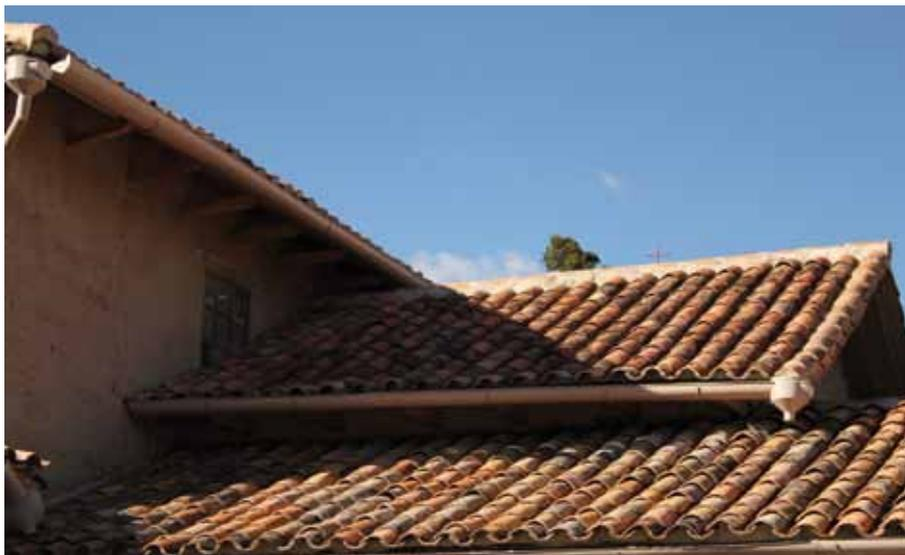
Finalmente, se remata con el cumbrero, que esta conformado por tejas con un traslapo no inferior a 5 cms.; se colocan sobre una cama de barro, la cual puede tener un agregado adicional de cal con el objetivo de que ayude a evitar la humedad.
