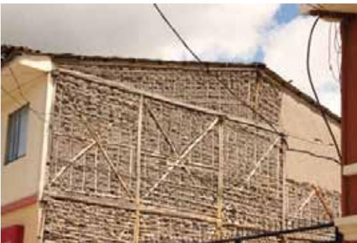
Solo una vez seco el barro, se da inicio al proceso de revoque y empañetado que se aplica de la misma manera y condiciones antes referidas.
