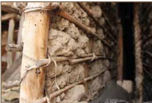
El barro a utilizarse para el embutido, se recomienda que sea reposado, no menos de 48 horas. La observación respecto a conservar la cascara del carrizo, se aplica también en esta técnica, este ayuda para que el barro se adhiera. Se puede adicionar desperdicios de teja o ladrillo para acelerar el proceso de secado; se debe tener la precaución de no exponer a un proceso de secado acelerado.
