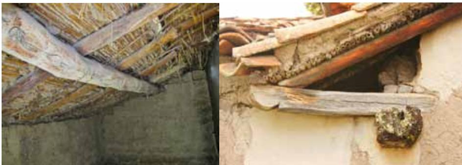
Es necesario recordar que no es conveniente el apoyo directo sobre los muros, se estaría generando una carga puntual sobre éste que podría afectarlo directamente; se recomienda asentar viga sobre otra que distribuya la carga y que permita el confinamiento adecuado.
