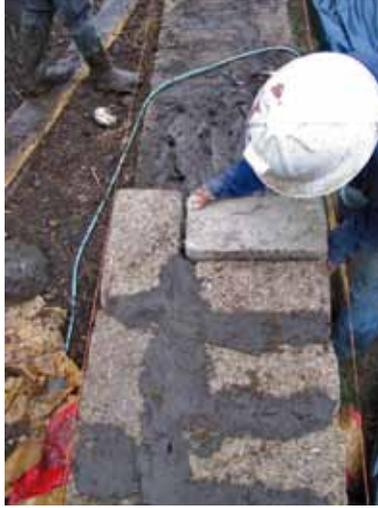
*Construcción de un muro de "tres adobes" (60cm.)*
