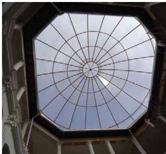
Obra de restauración
