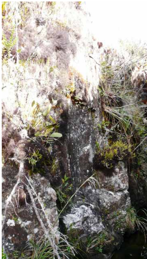
Foto 25 Pared irregular de canal de desagüe
