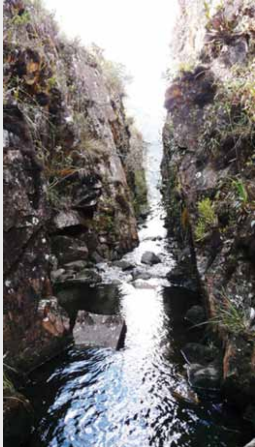
Foto 27 Tramo de canal de desagüe con vegetación reciente
