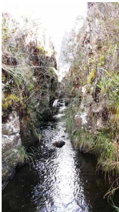
Foto 26 Tramo de canal de desagüe con vegetación antigua
