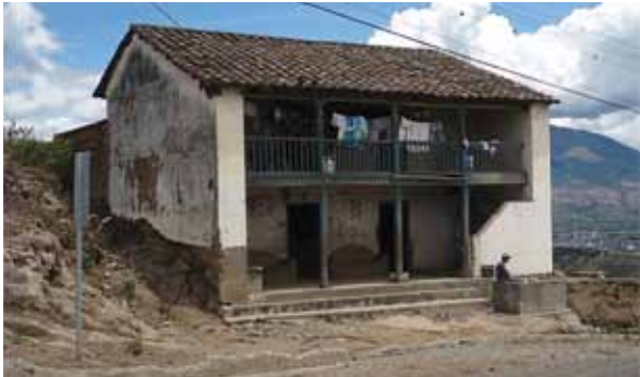
Techo a dos aguas
