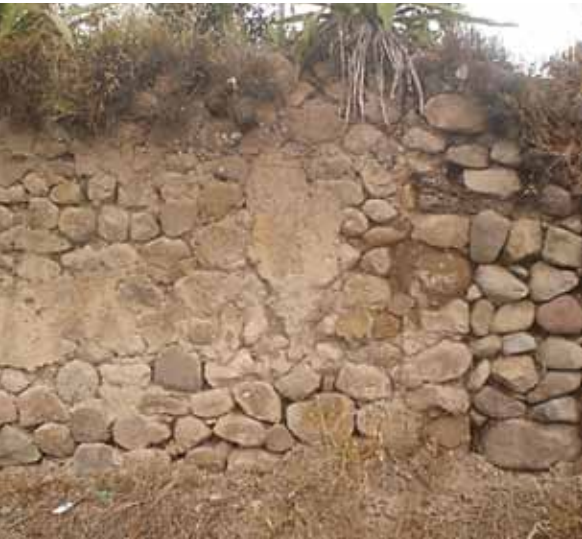
Mampostería de piedra
