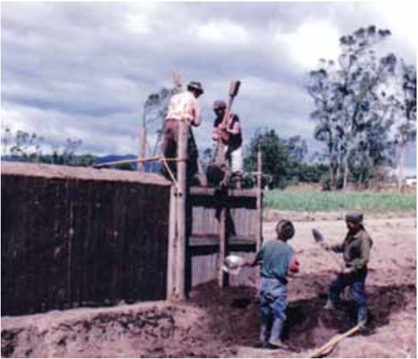
Minka para la construcción de un tapial
