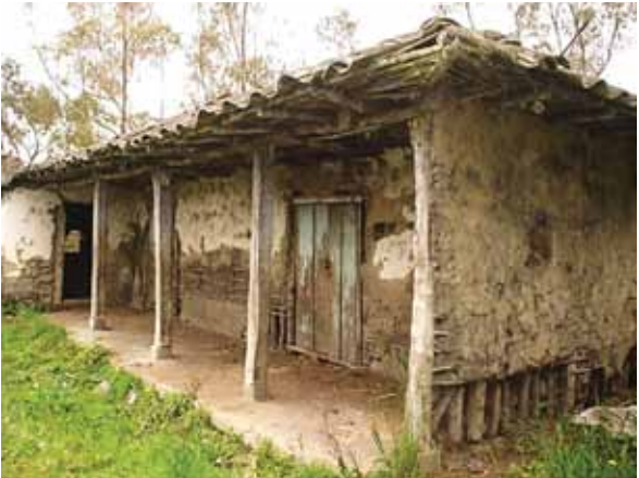
Pilar de vivienda
