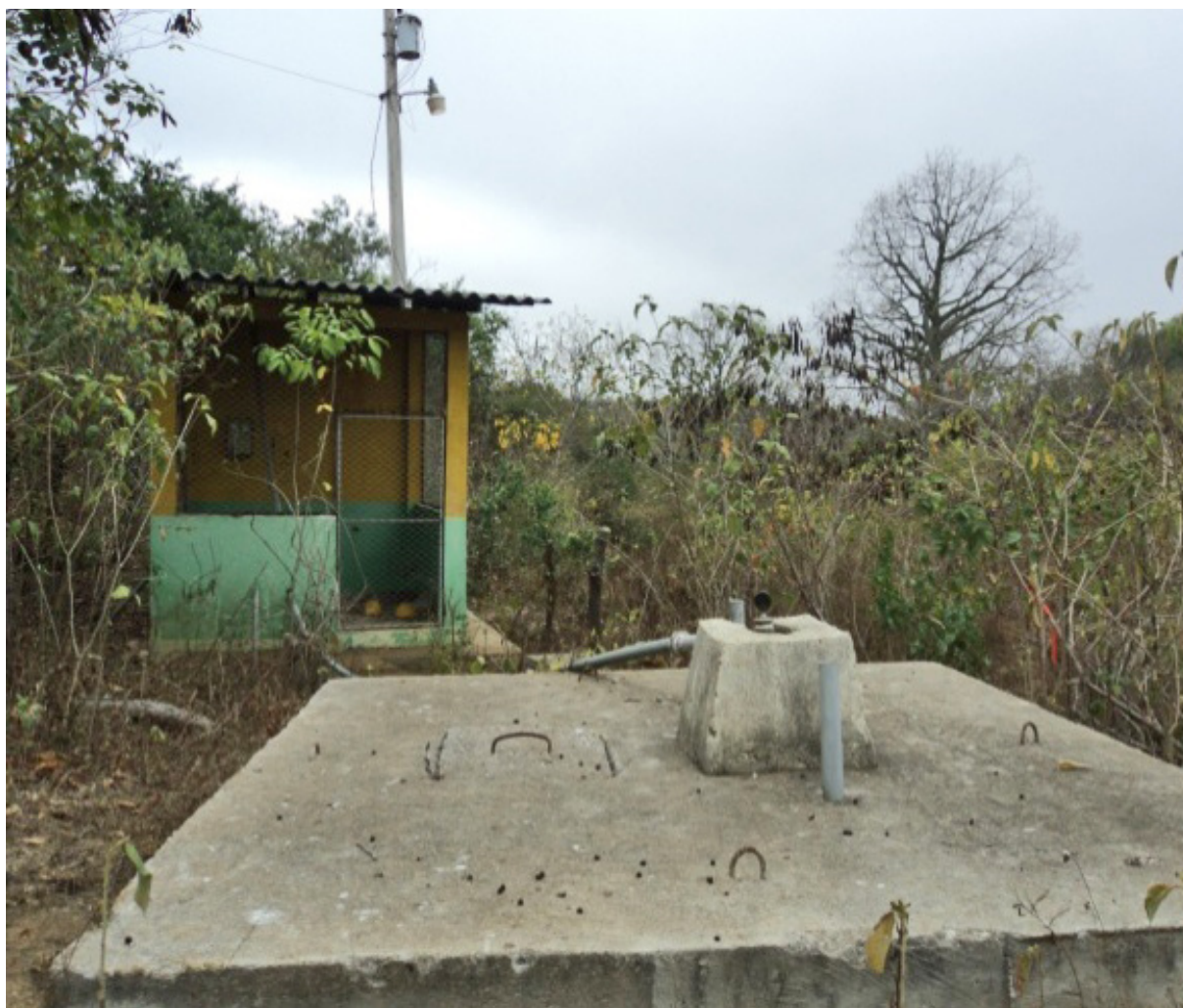
Pozo de la Bomba
