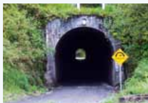
Túnel Agoyán, Baños.
