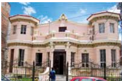
Inmueble de la ciudad de Riobamba
