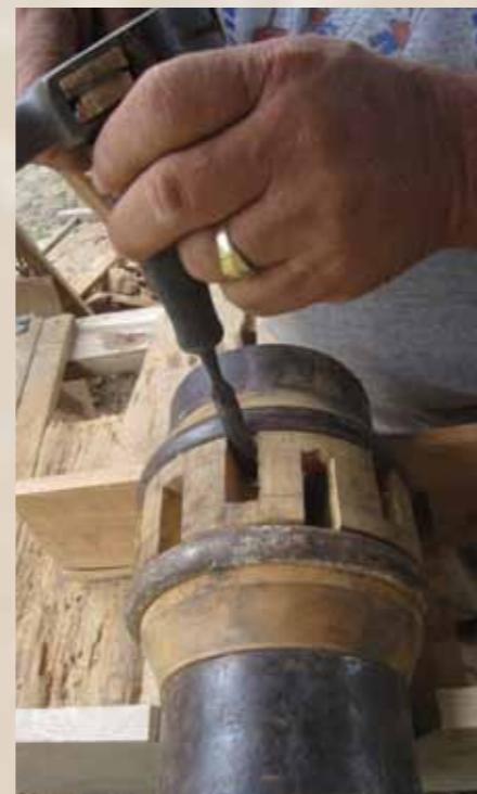
Los xilófagos destructivos habían formado cavernas internas en varios elementos de madera.
