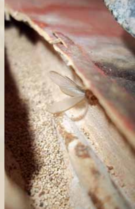
Los xilófagos destructivos habían formado cavernas internas en varios elementos de madera.
