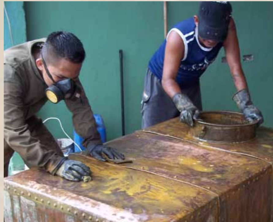
Limpieza profunda química del tanque de cobre.
