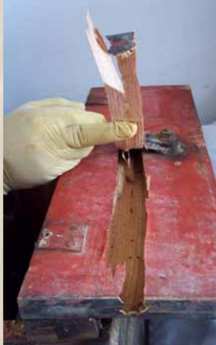
Los xilófagos destructivos habían formado cavernas internas en varios elementos de madera.
