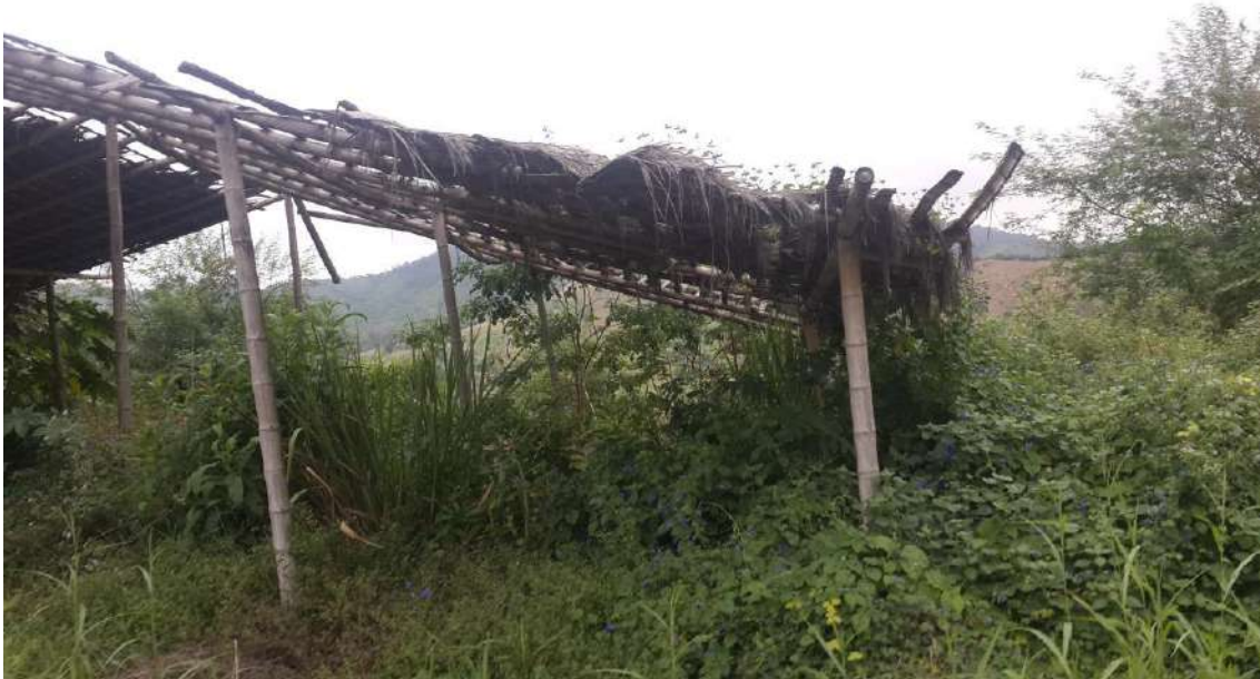
Foto 13 Registro actual. Ejemplo de desprendimientos de partes de cubierta que precipitan en caída libre.
