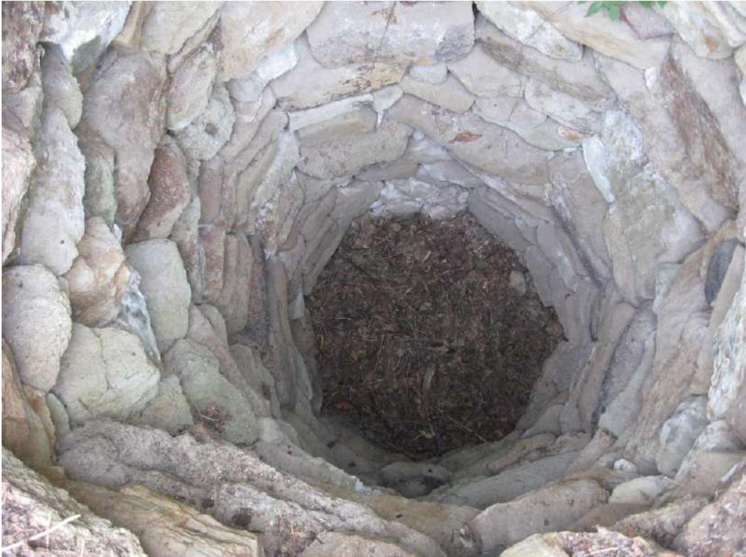
Pozo de agua L247. La estructura está completamente intacta pero, por el relleno de suelo en el fondo, no tiene agua.
