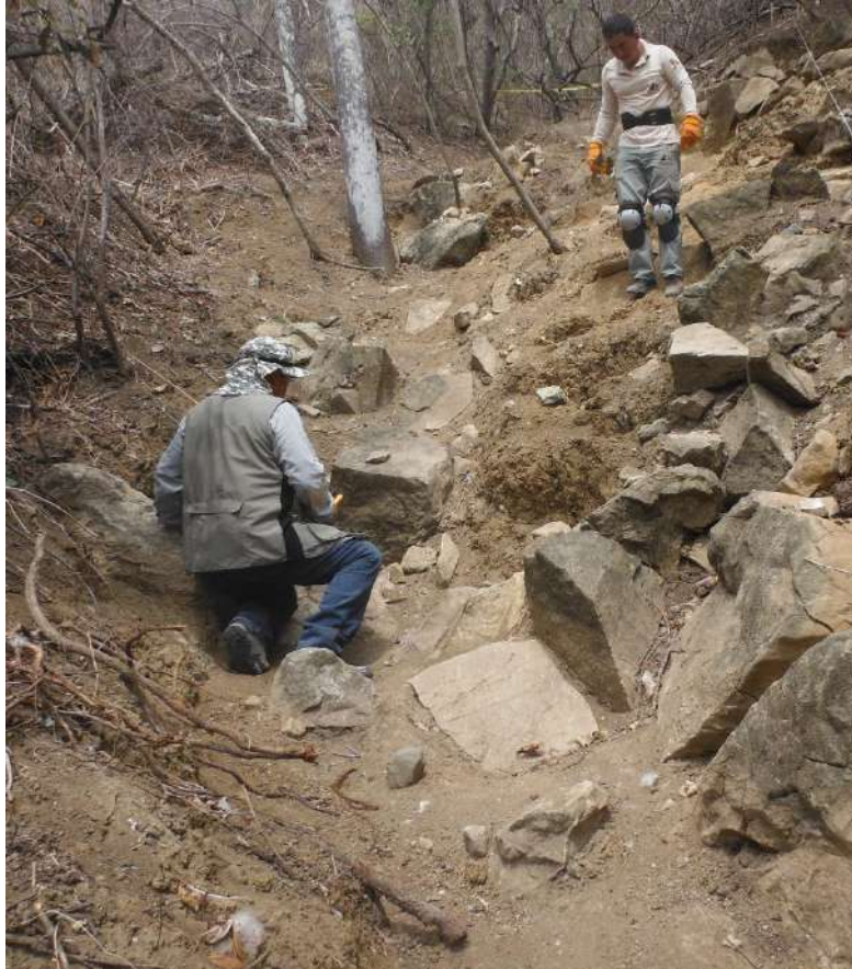
Foto 46 Estado en que quedó la excavación de la cantera
