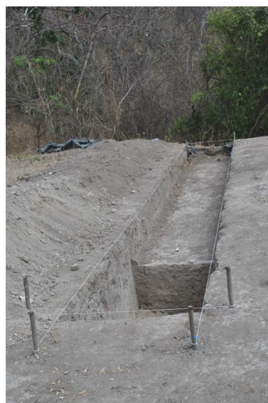
Fotos 18 y 19: estado de las trincheras C2T2 (izq.) y C2T1 (der.)
