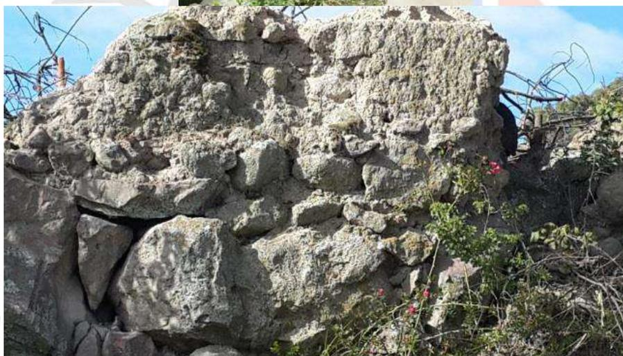
Foto 1 Ejemplo de pared de tapias. Foto M.Suárez Foto 2 Detalle de las piedras basales del tapial, amorfas
