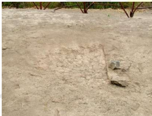
Foto 9. 2cm excavados del 25% de la depresión
