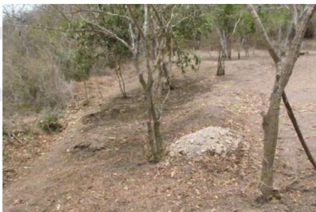
Foto 22, 23 y 24: limpieza con machete, rastrillo y escoba del sector Sur exterior a la Estructura C1
