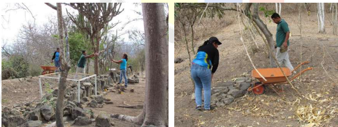
Fotos 53 y 54: retiro y disposición de las piedras no fijas en el suelo del interior de la Estructura C1
